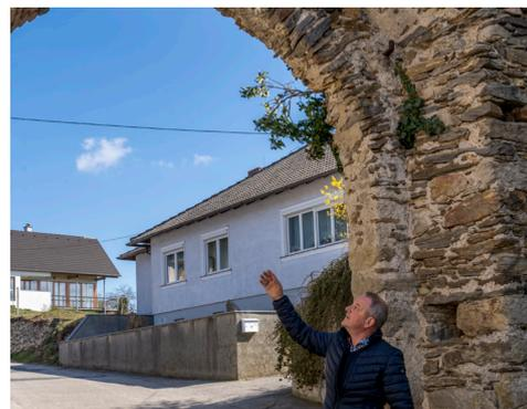
Das Mauerwerk des Tores leidet vor allem unter dem Bewuchs. Der Efeu sprengt das Mauerwerk und muss entfernt werden. Lose Steine werden ergänzt.
