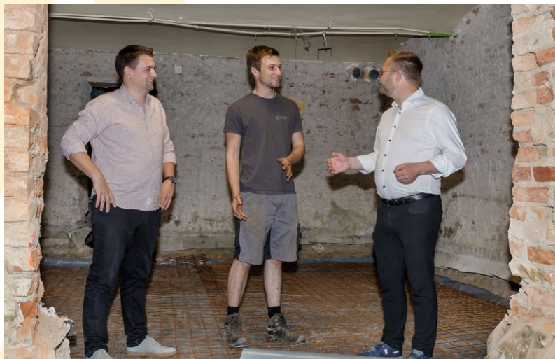
Vereinsobmann Stefan Schiller bei der gemeinsamen Besichtigung der Bauarbeiten mit Stadtrat Michael Schamann und Bürgermeister Erich Stubenvoll
